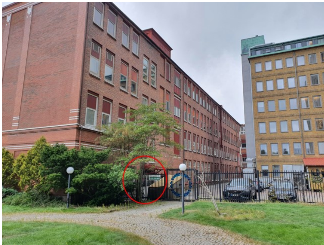
Figur 18. I figuren visas riskområde vid skyfall i anslutning till entrén till befintlig byggnad. Befintlig entré markeras med röd ring. Källa: Tyréns
