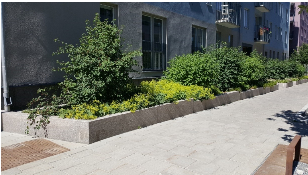
Figur 21. Exempel på biofilter intill byggnad. Källa: Tyréns.
